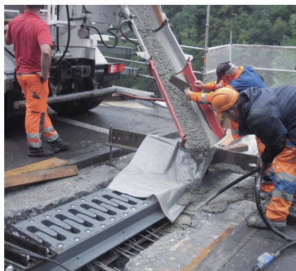
Einfüllen des Betons Q-FLASH 2/20
