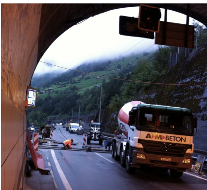
Betoniervorgang am Fahrbahnübergang
