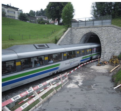
Pünktlich der erste Zug am Montag Morgen nach der Sanierung
