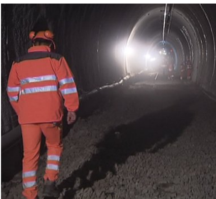
Sohle vor dem Absenken
