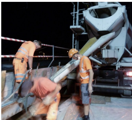
Einbau mittels Fahrmischer
