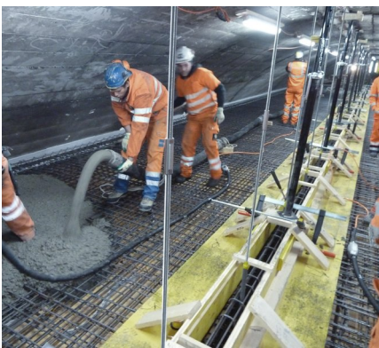
Pumpförderung auf Zwischendecke
