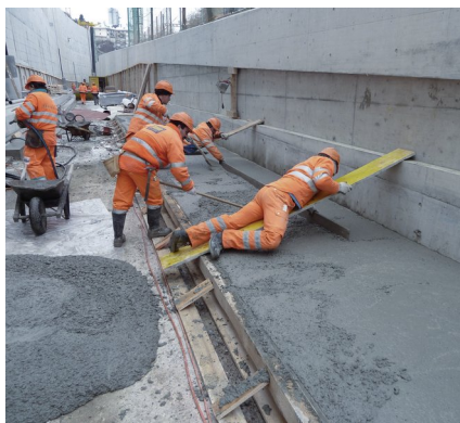
Einbau der Randborde
