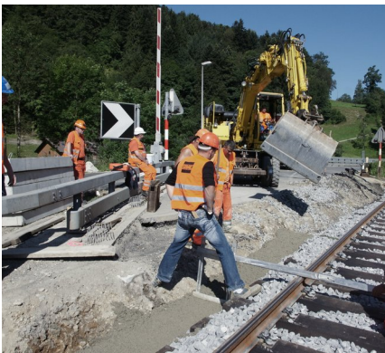
Vorlegen des Schnellbetons Q-FLASH 2/20
