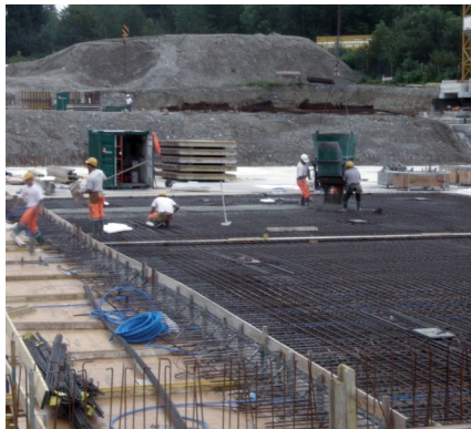
Einbau der Bodenplatte
