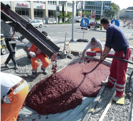
Einbau des eingefärbten Faserbetons
