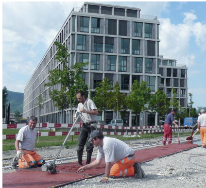
Abziehen des Faserbetons
