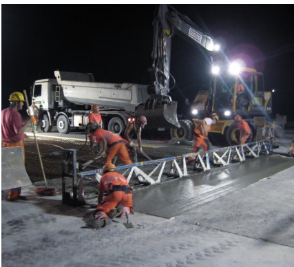
Beginn der Betonarbeiten
