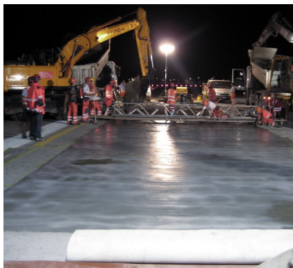
Einbringen des Betons
