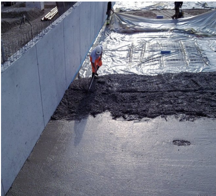
Einbringen des Faserbetons
