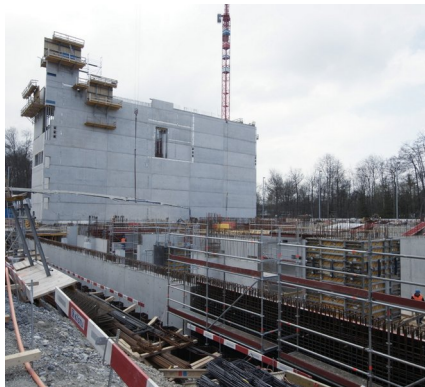
Baustelle im April 2010
