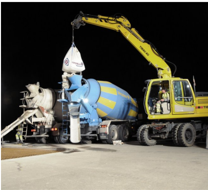
Betonproduktion direkt im Fahrmischer
