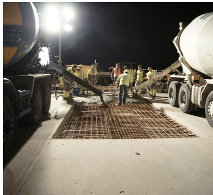
Einbringen des Betons
