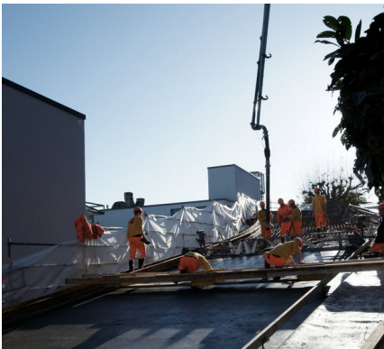
Einbau des Betons im Gefälle
