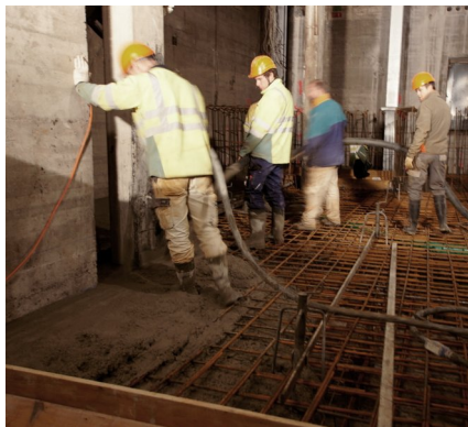
Einbau mit dem Saniermobil
