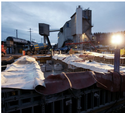
Baustelle BAB Belagswerk Birmensdorf
