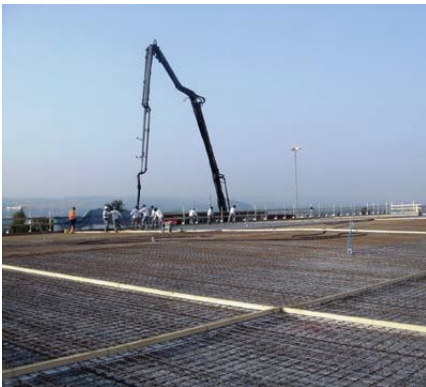
Vor dem Einbau
