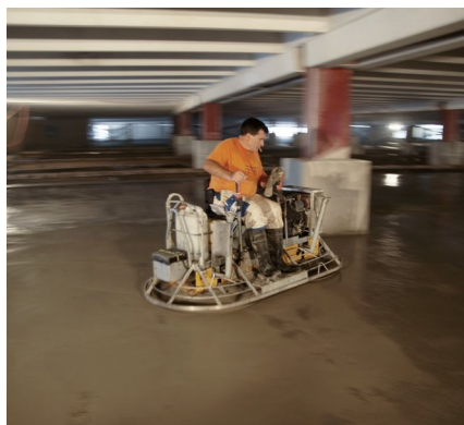
Abflügeln der Betonoberfläche
