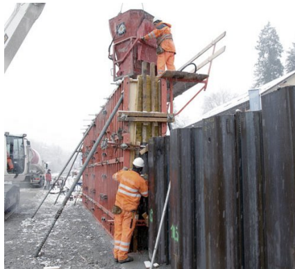
Première étape de bétonnage
