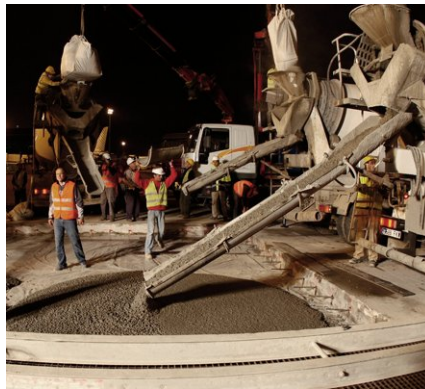
Betonieren der Platte
