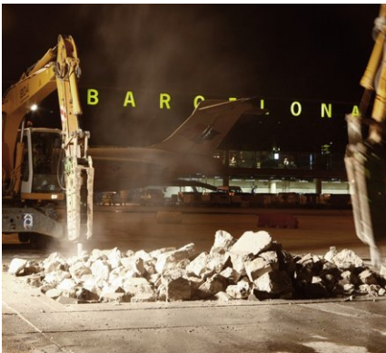
Rückbau der alten Platte
