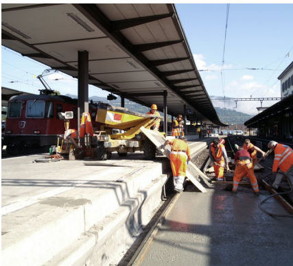
Einbau des Betons ...
