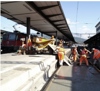
Einbau des Betons ...
