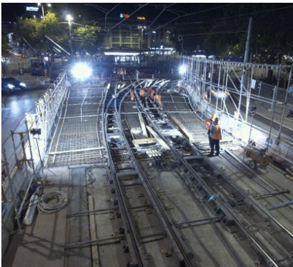
Vor dem Betonieren um 21:00 Uhr
