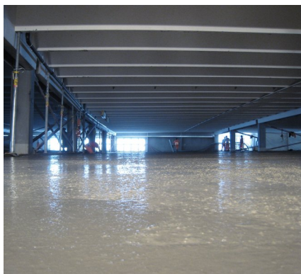
Abgezogene Betonoberfläche
