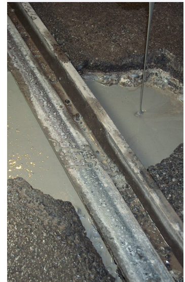
Anwendung zum Beispiel bei Unterhaltsarbeiten an Tramschienen
