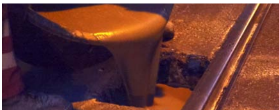
Tramgleisunterfüllung mit Q-FILL
