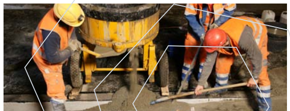
Brückensanierung mit Q-REP 1/20
