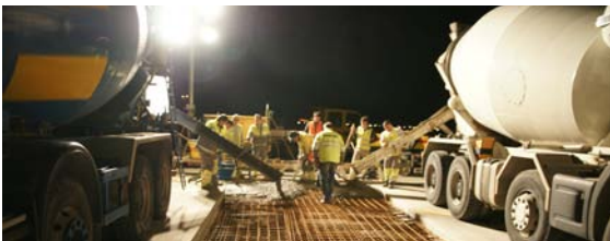
Einbau direkt aus dem Fahrmischer
