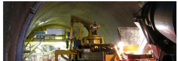
Instandsetzung Lawenschutzunnel Mitholz mit D-ZERO Plus, BE
