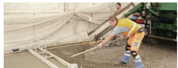
Brückeninstandsetzung mit Concretum® C-DRY
