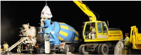
Zugabe des Bindemittels auf der Baustelle
