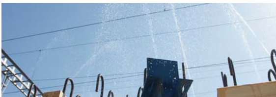
Nachbehandlung mit Wassersprinkler
