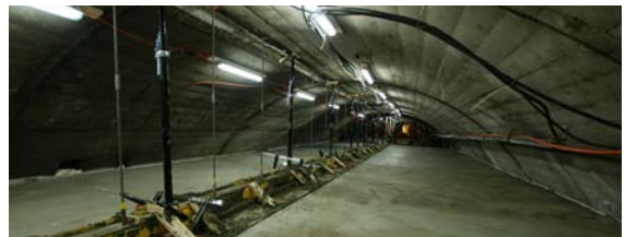
Zwischendecke im Sonnenbergtunnel, Cityring Luzern
