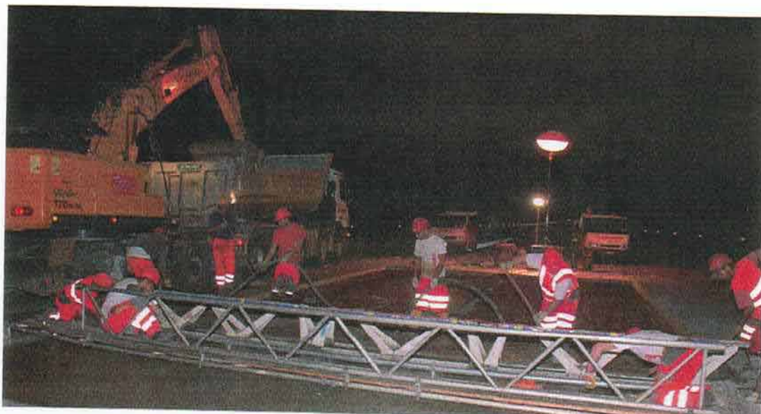
Die alte Betonplatte wurde herausgespitzt und mit Stahlarmierungen versehen. Nun wird der Schnellbeton eingefüllt, der sofort glatt gestrichen werden muss. Zwei Stunden später können hier bereits Flugzeuge landen.
