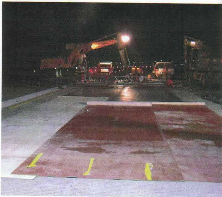
Meter für Meter arbeiteten sich die Bauarbeiter vor. Der heikelste Arbeitsschritt war das Betonieren, weil der Schnellbeton nach kürzester Zeit fest und zäh wird und nicht mehr bearbeitet werden kann. Vorne im Bild bereits ersetzte Betonplatten, die zum Trocknen noch abgedeckt wurden.
