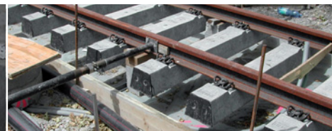
Aufgeständerter Gleisrost vor dem Betonieren
