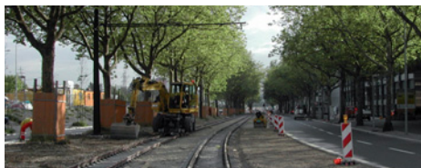
Einbau des Schotterterrassens
