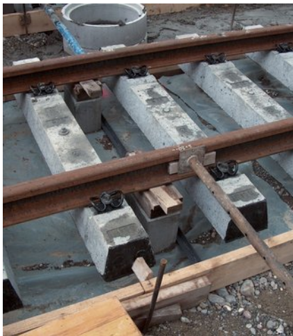
Gleisrost, aufgeständert und ausgerichtet
